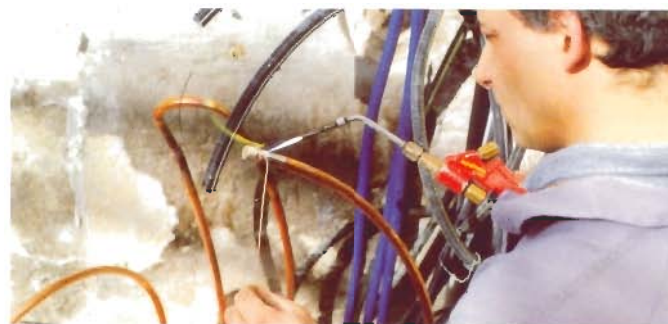
L'équipe intervenue sur le chantier de la véranda a été surprise par la facilité de pose du système.
